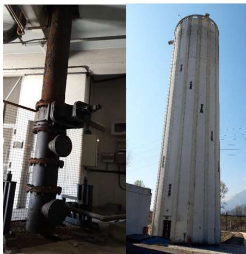
Vues sur le réservoir sur tour Z10 et sa conduite d'alimentation-distribution en DN400
